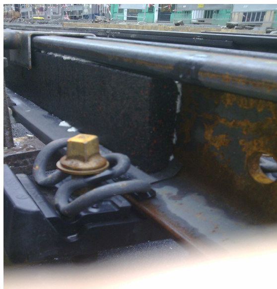
▲ systém izolace kolejnice ORTEC ISOLast Eco dokonalá izolace paty kolejnice a úzké bokovnice
