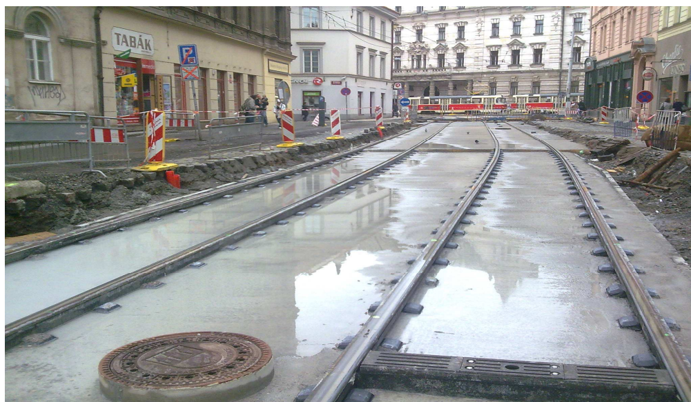
▼ výroba betonové desky
