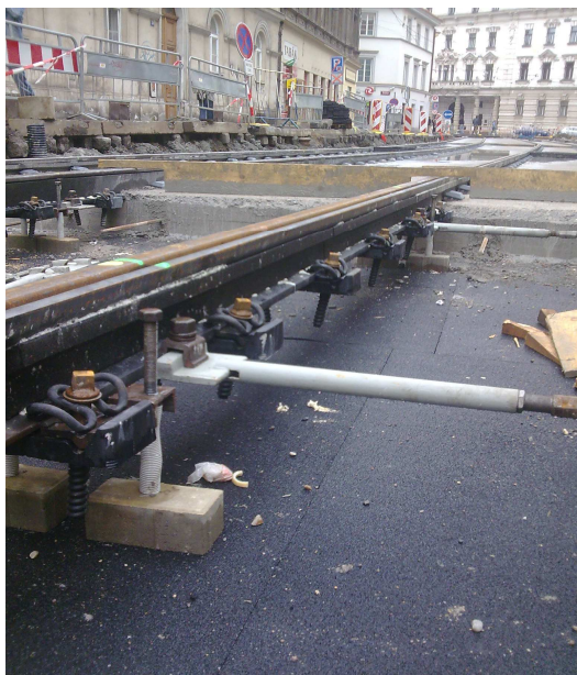
▲ montáž upevnění a podšterkových rohoží
