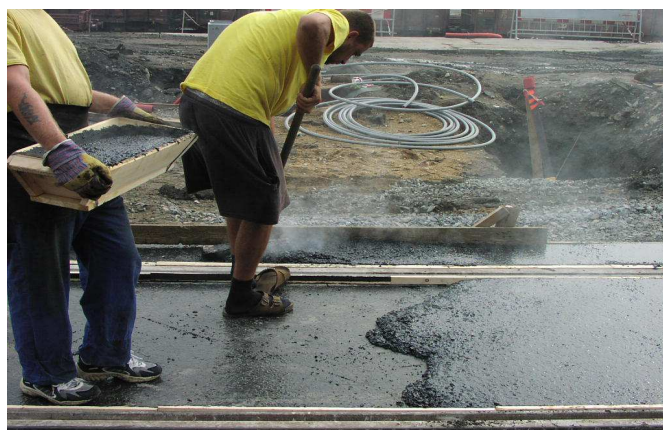
Aplikace litého asfaltu
