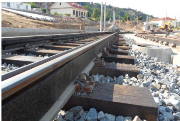
▲ izolace srdcovek ◀▼ systém ORTEC ISOLast Eco
