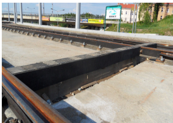
▲ izolace odvodňovačů
