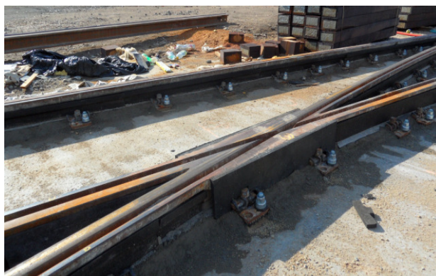
▲ izolace srdcovek ◀▼ systém ORTEC ISOLast Eco
