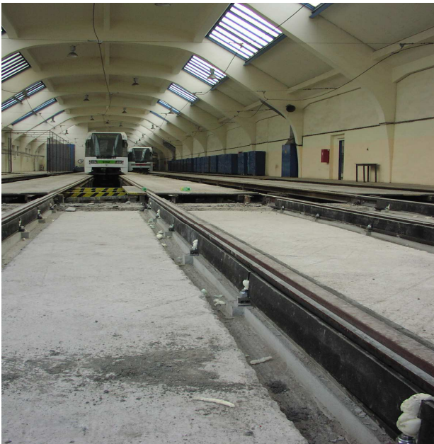
Ukázka vyrovnání kolejnice a její podlity nivelační zálivkovou maltou ORTEC.grout Rapid a tentýž úsek po rekonstrukci.
