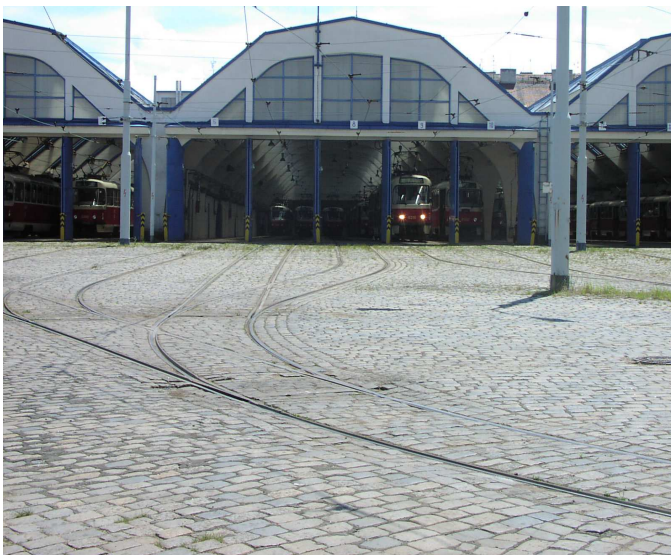
Úseky před halami před rekonstrukcí
