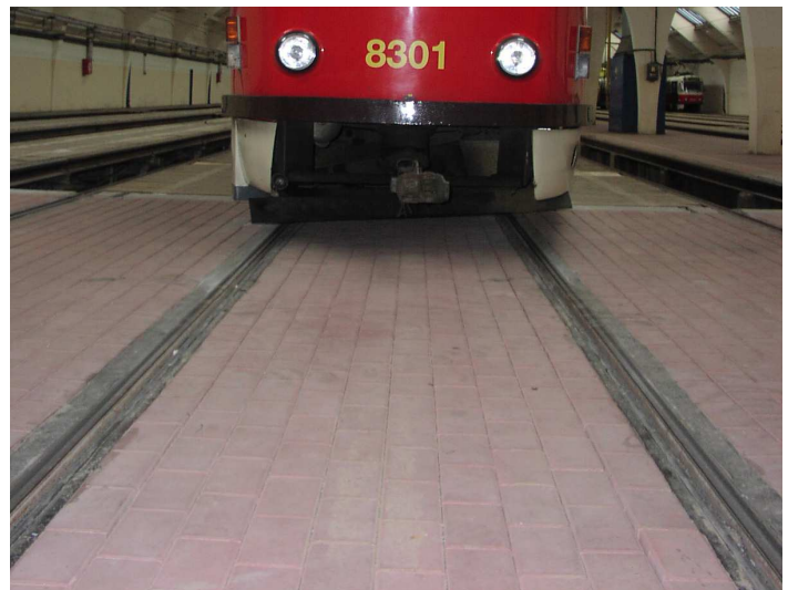
Ukázka vyrovnání kolejnice a její podlity nivelační zálivkovou maltou ORTEC.grout Rapid a tentýž úsek po rekonstrukci.
